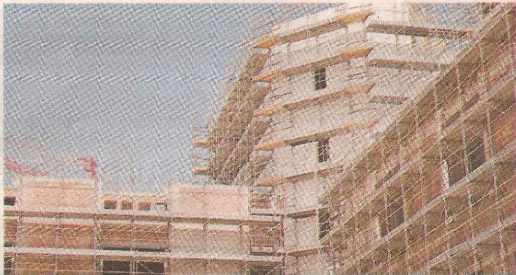
Il nuovo monoblocco in costruzione. FOTO D'ARCHIVIO
